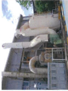
Cyclone อนุกรมกับ Bag Filter
